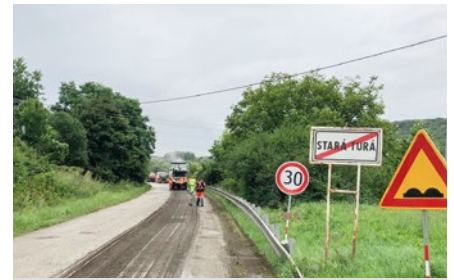
■ rekonštrukcia úseku cesty III. triedy Stará Turá – Vaďovce
