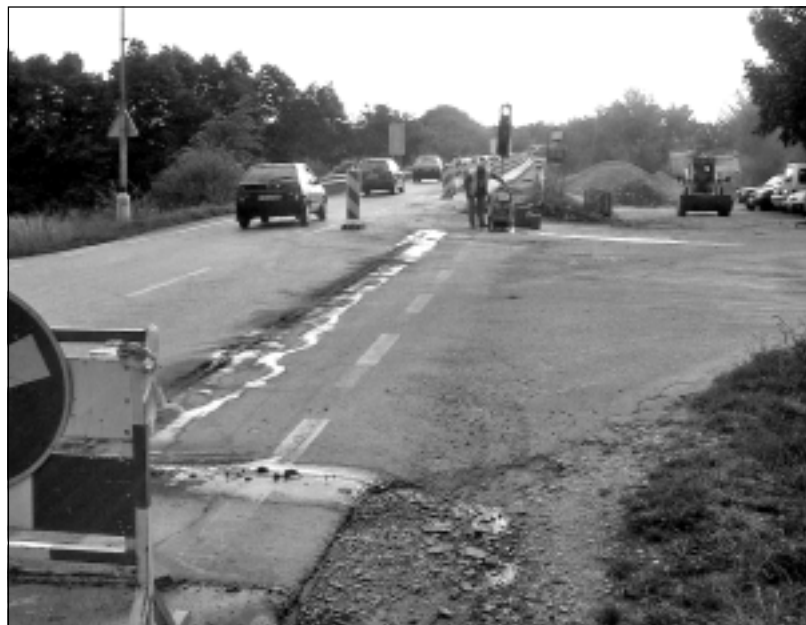
Kanalizácia na Husitskej ceste by mala byť ukončená v októbri 2007. Foto Mikláš
